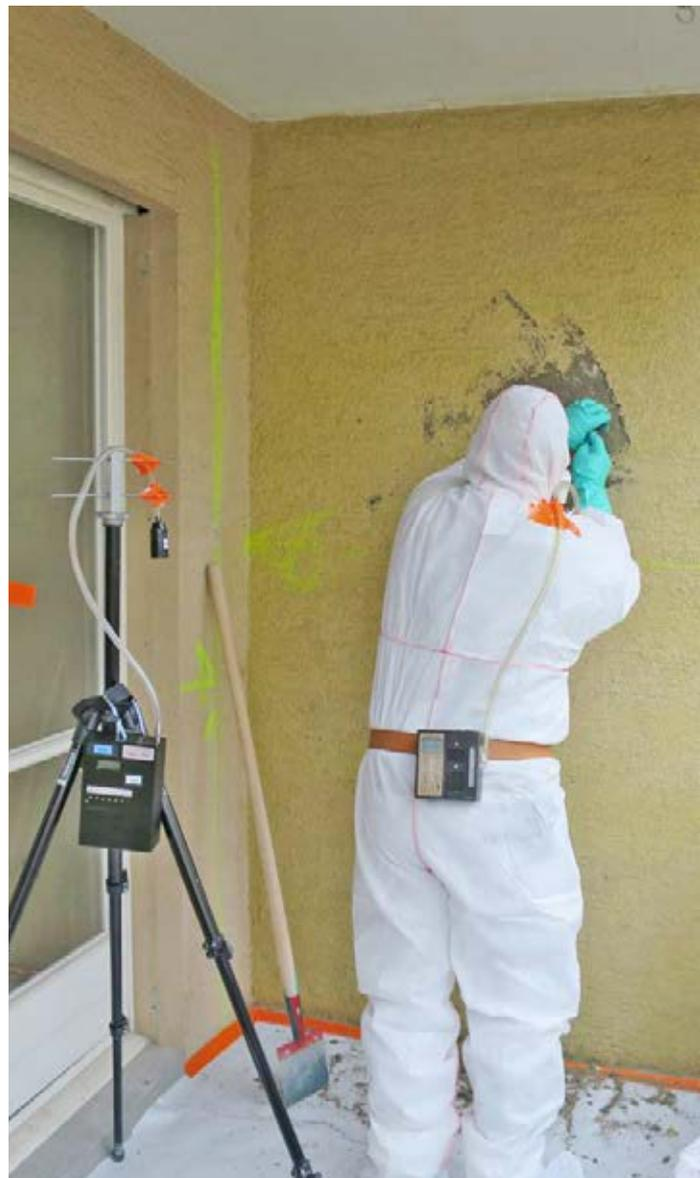
Stationäre und personenbezogene Luftprobenahme bei der Entfernung von Fassadenputz.
